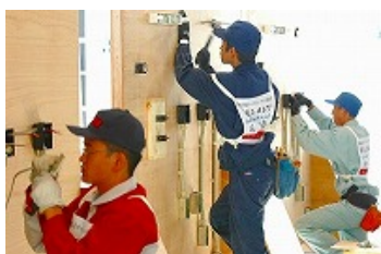
電気工事部門
