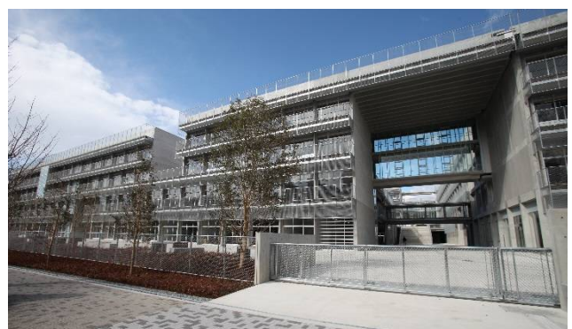
写真4 竣工時に正門から見た校舎
