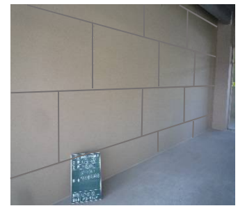
写真3 ボード下張り
