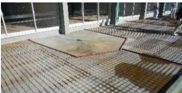
写真2 勾配コンクリート打設前
