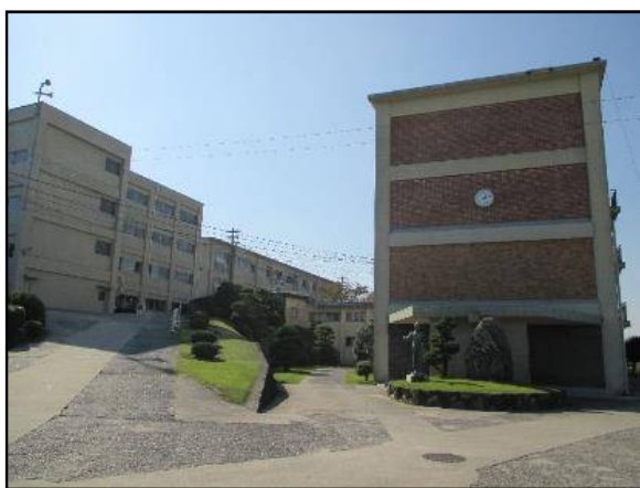
写真1 本校校舎外観
