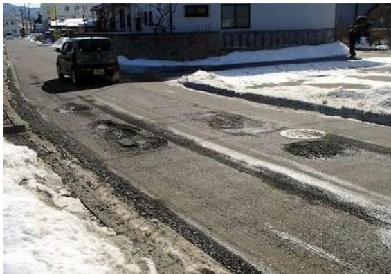
図1 凍害による劣化（盛岡市2018）
