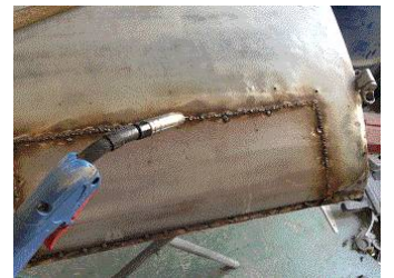
図5 腐食部分の補修
